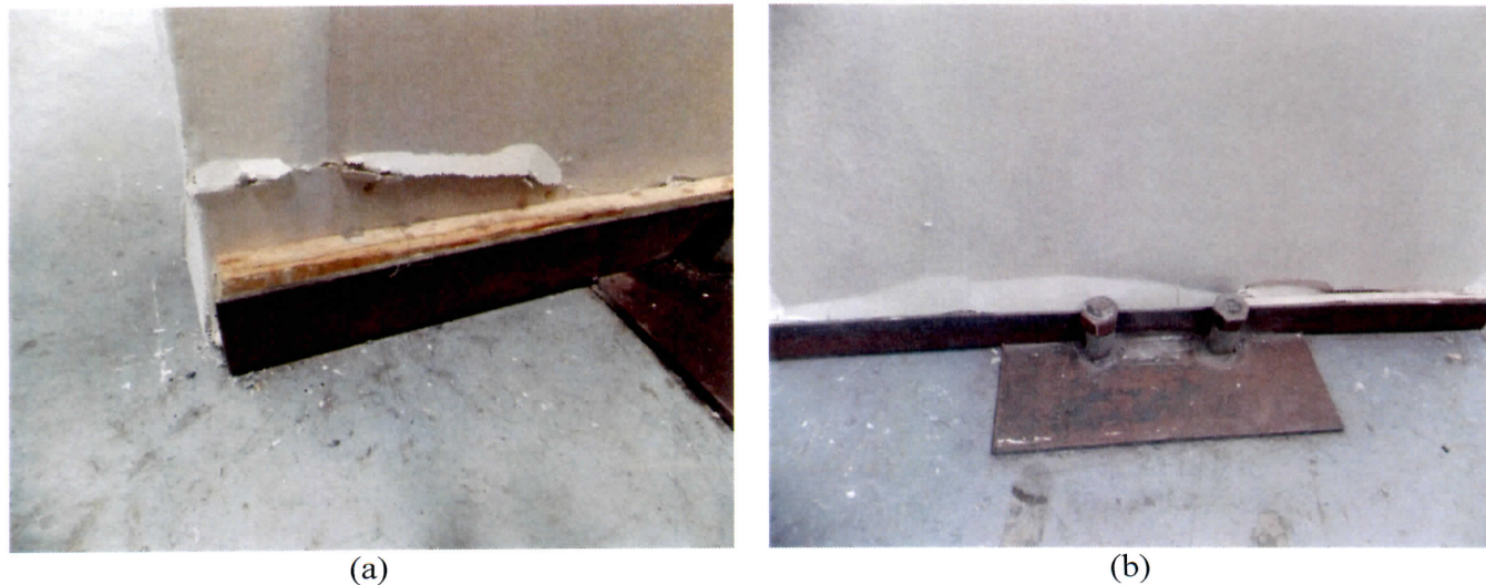
Figura 4. Falla en compresión muestra 1892-15 (2): a) vista posterior, b) vista frontal.
